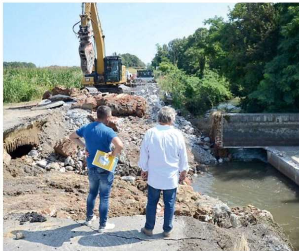
Lavori a Torrevecchia Pia per riaprire il cavo Marocco bloccato dal crollo della strada
